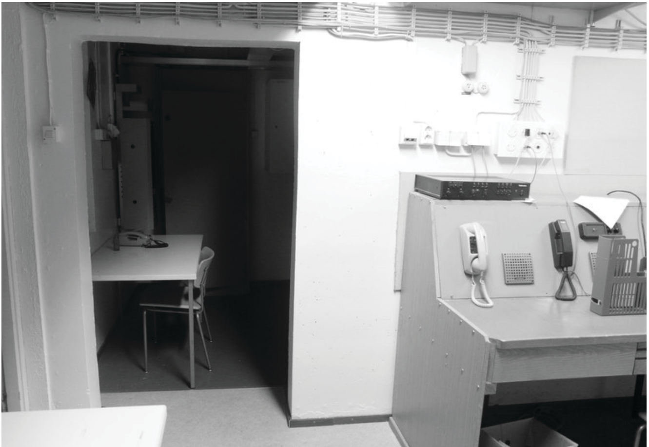
Old bunker in Seinäjoki, kuva Alan Bulfin
